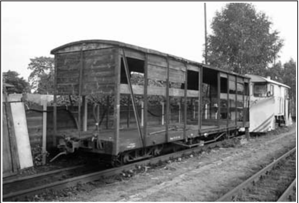
Die Freilegung des Untergestells von 97-09-77 hat bereits begonnen. Foto: R. Fischer
